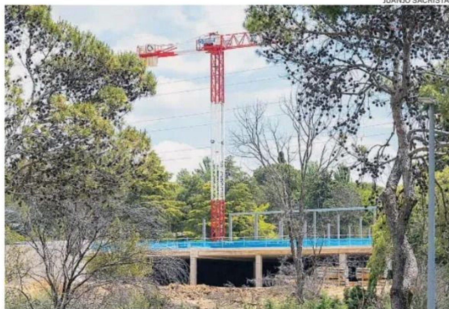
Obras de reconstrucción en el complejo de Boadilla
